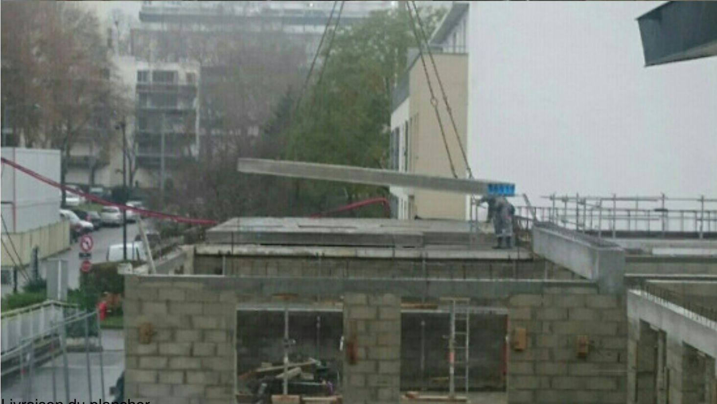
Livraison du plancher
