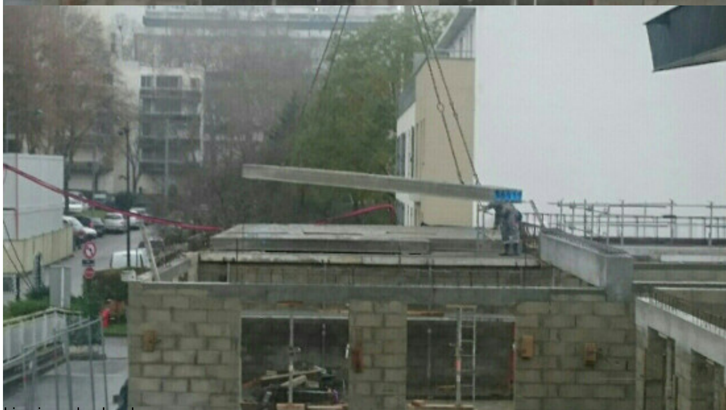
Livraison du plancher
