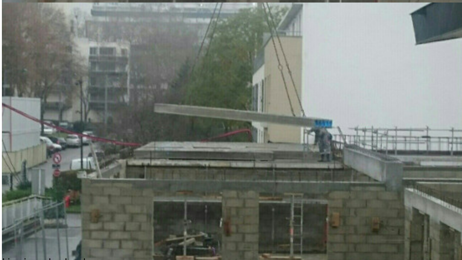
Livraison du plancher
